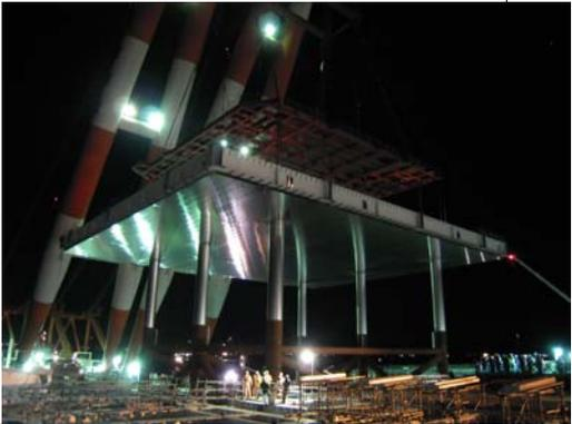
写真；棧橋部ジャケット198基目据付状況 (H22. 01. 26 撮影)
