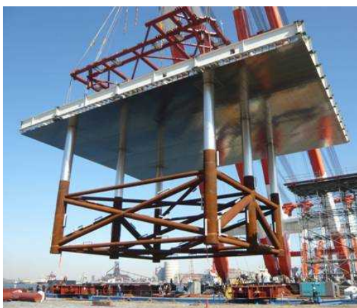
栈橋部ジャケット
