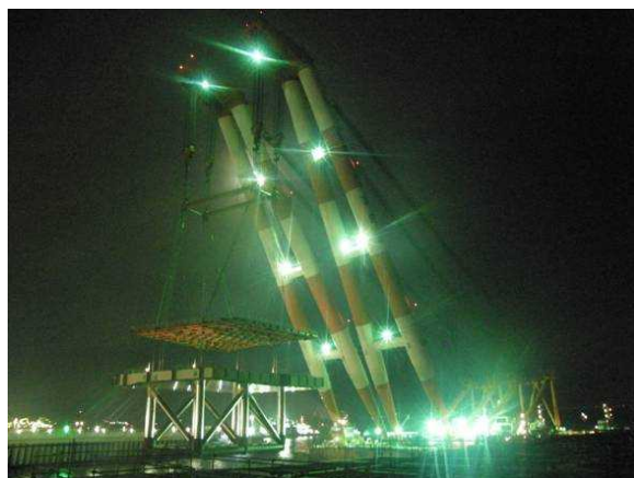
ジャケット据付状況（夜間）
