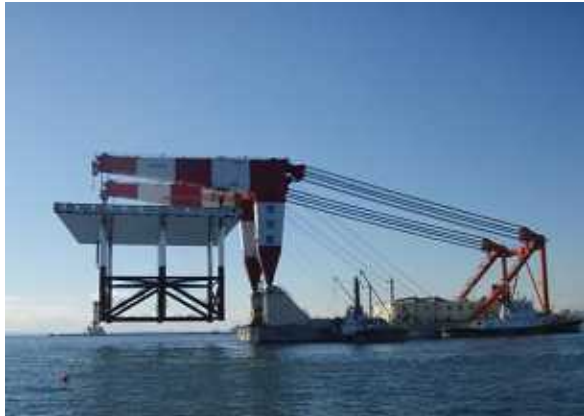
写真；栈橋部ジャケット 100 基目据付状況(H21. 1.11 撮影)
