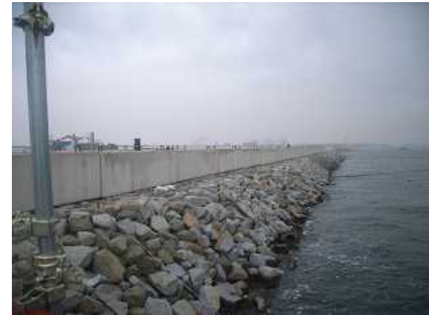
上部ブロック・据付状況
