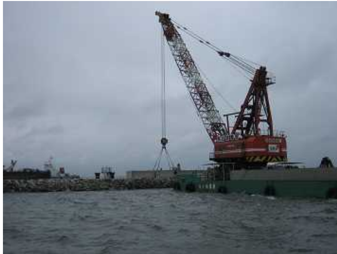
埋立 工区現空港側据付
