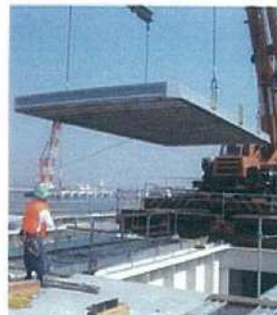
上部工(UFC床版工)
