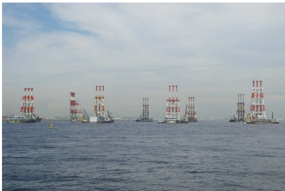
昼間作業状況
