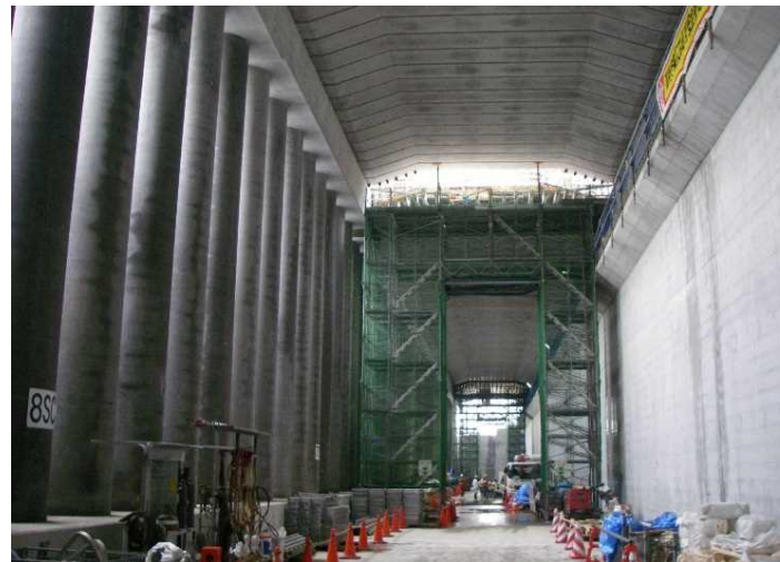
2009年6月接続部井筒護岸施工
