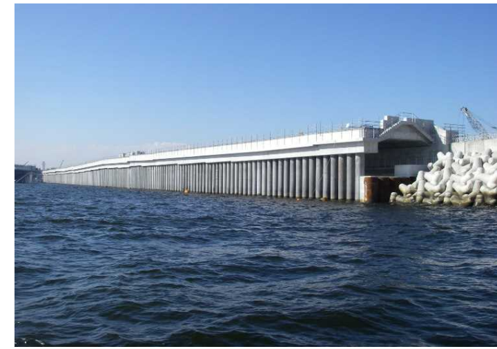
2009年9月接続部(栈橋部側から)
