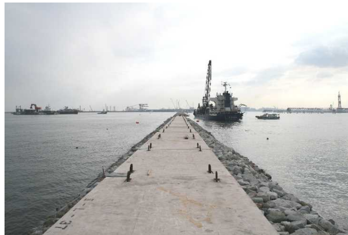
2008年8月埋立部護岸上部ブロック
