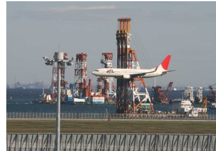
2007年11月地盤改良工事
