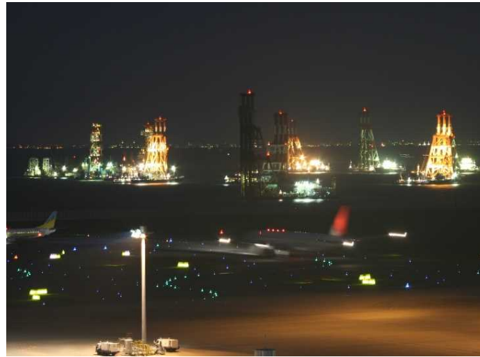
2007年10月夜間地盤改良工事
