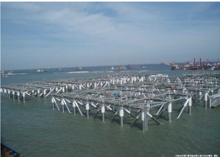
2008年1月ジャケット一体化施工
