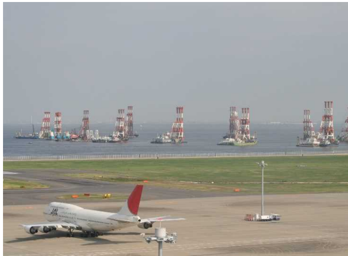
2007年10月地盤改良工事
