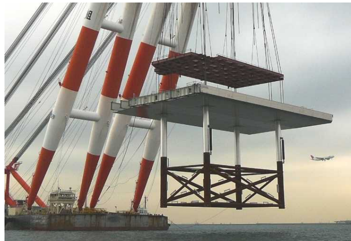
2008年1月ジャケット据付工
