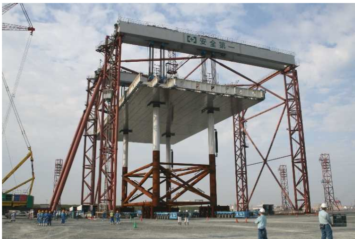
2008年1月ジャケット一体化施工
