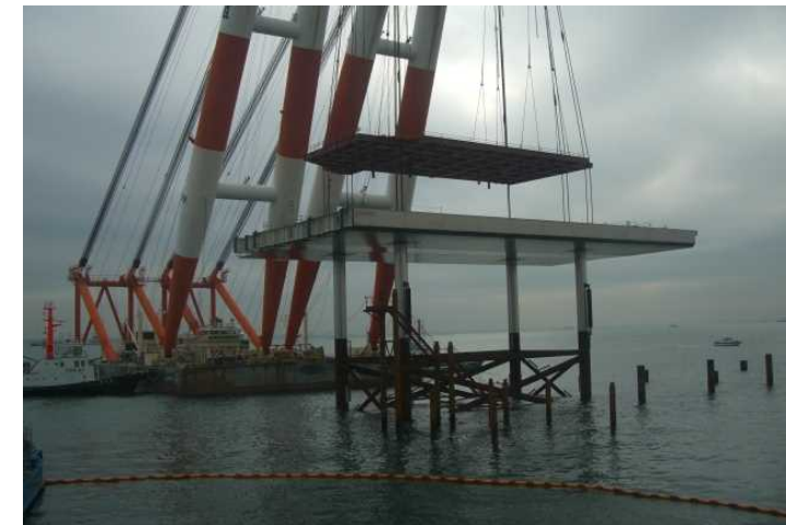
2008年1月ジャケット据付工
