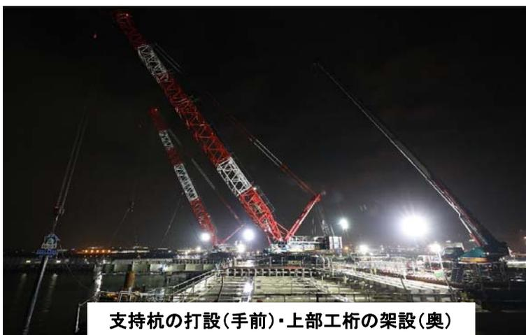
支持杭の打設(手前)・上部工桁の架設(奥)
