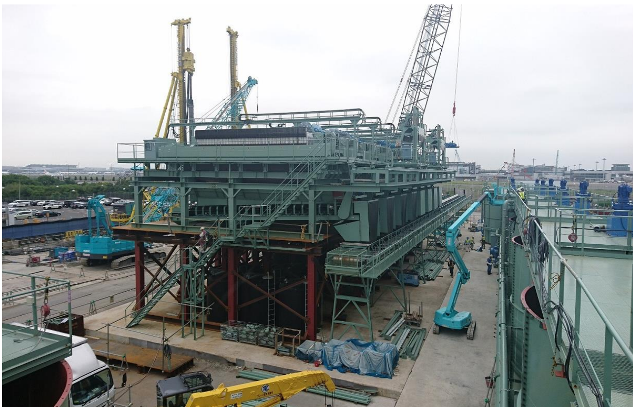
写真② 泥水処理設備設置状況
