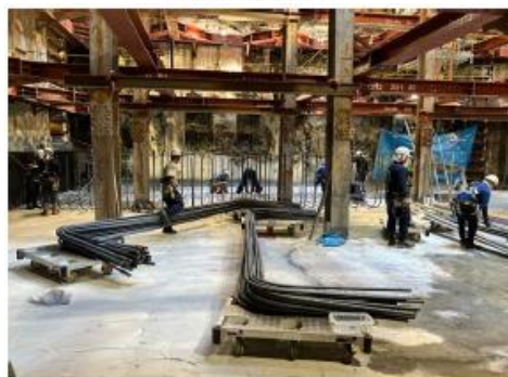
底板鉄筋組立状況
