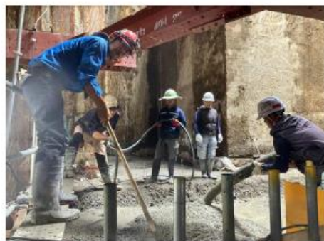
均しコンクリート打設状況
