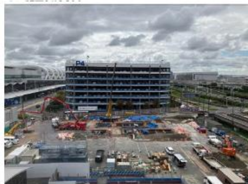
現場全景 (9/23時点)
