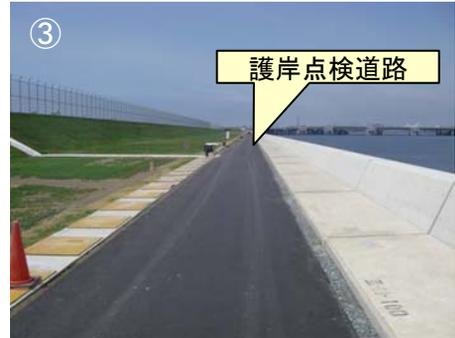
①②...埋め立て部の場周柵の支柱の施工状況です。場周柵の施工は、まずプレキャストのコンクリート基礎を設置し、支柱を立てフェンスを設置しています。③...護岸点検道路の舗装後状況です。
