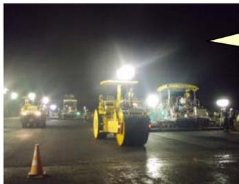
ローラーによる転圧状況です。アスファルト敷き均し後、ローラーで転圧して締め固めます。
