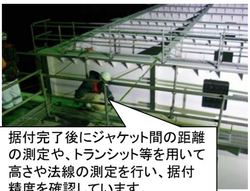
据付完了後にジャケット間の距離の測定や、トランシット等を用いて高さや法線の測定を行い、据付精度を確認しています。
