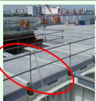
⑥設置されたUFC床版です。床版と床版の間は、コンクリートで埋められ、その上に、防水剤が塗布されます。
