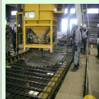
③どろどろの状態のUFCを、引張った鋼線を配置した型枠に流し込みます。その後、UFC床版は養生という、温度、水分管理のプロセスを経て固まっていきます。
