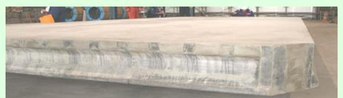
④養生を終えて、床版のかたちが見えてきました。この後、床版の側面をコーティングしてUFC床版が完成します。
