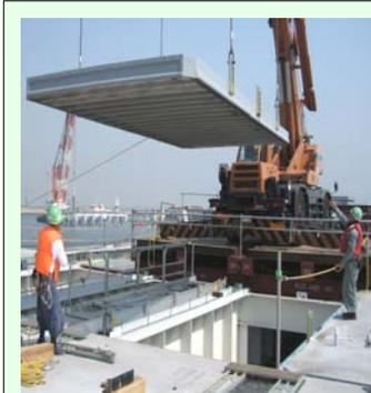
⑤工場で製作されたUFC床版は、羽田の現場まで船で運搬され、設置されます。写真の床版の寸法は、およそ縦8m、横3.5mです。
