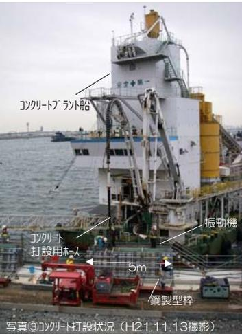
↑コンクリートポンプ船によるコンクリート打設状況。写真のように、堤外（海上）からコンクリートを打設します。
