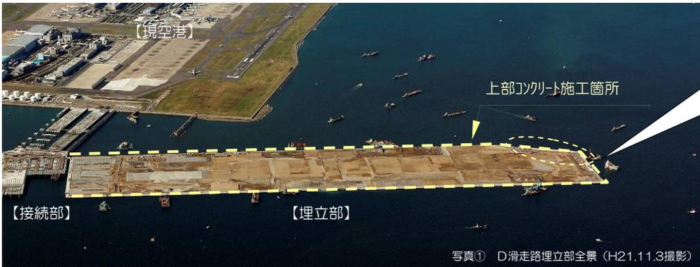
破線箇所がパラペットの施工線を示しています。（接続部護岸部を除く埋立部全域）
