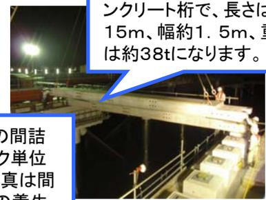
渡り桁は、プレキャストコンクリート桁で、長さ約15m、幅約1.5m、重量は約38tになります。
