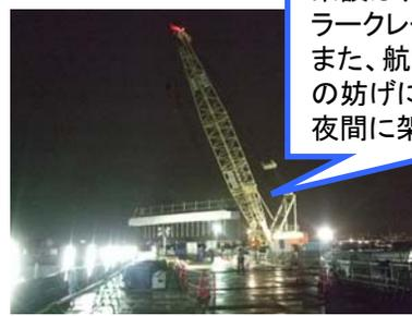
架設は、150tのクローラークレーンで行います。また、航空機の離発着の妨げにならないように夜間に架設しています。
