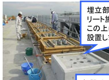
埋立部側の台座コンクリート施工中の様子です。この上にゴムの支承を設置します。
