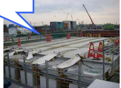
写真はH21年10月現在の渡り桁の架設状況です。ジャケット据付に伴い、順次架設されます。来年の5月には、渡り桁が全て架設される予定です。また、今後は埋立部の沈下に対応した伸縮装置も順次設置されていきます。
