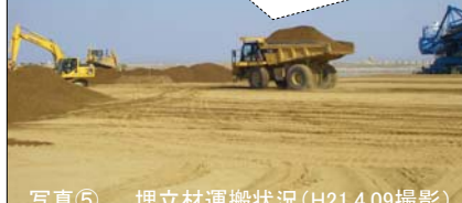
写真⑤ 埋立材運搬状況 (H21.4.09撮影)
