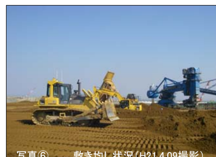
写真⑥ 敷き均し状況 (H21.4.09撮影)
