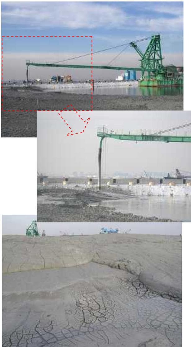
管中混合固化処理工が本格化する埋立部。
