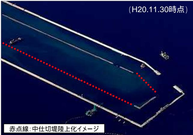
羽田空港D滑走路建設工事の埋立部では、護岸構造に配慮した「管中混合固化処理工」が進められていますが、同時に「中仕切堤工」も進められています。「中仕切堤工」とは簡単に言うと、管中混合固化処理土を打設する部分と埋立部を分ける「仕切り」を造る工種で、管中混合固化処理工と並行して進められます。海上部に見えるのは「中仕切堤2」ですが、海中部にある「中仕切堤1」の上に造られています。
