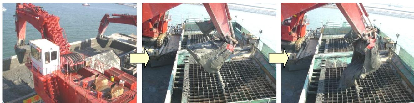
(写真下左&中) 投入された浚渫土は、船内のオペレーションルームで厳正にコンピューター管理されながら、空気圧を利用して、次の船（固化材供給船）を目指して押し出され、船団終端の打設船にたどり着くまで送り込まれます。
