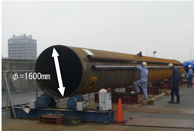
光ファイバセンサを取付ける鋼管矢板です
