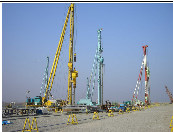
地盤改良工事(サンドコンパクション)の様子
