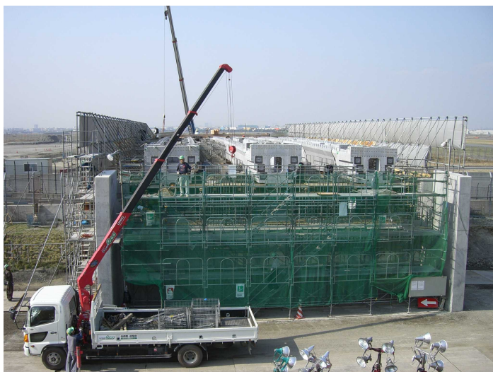
GSE橋梁のUFC桁架設後の様子
