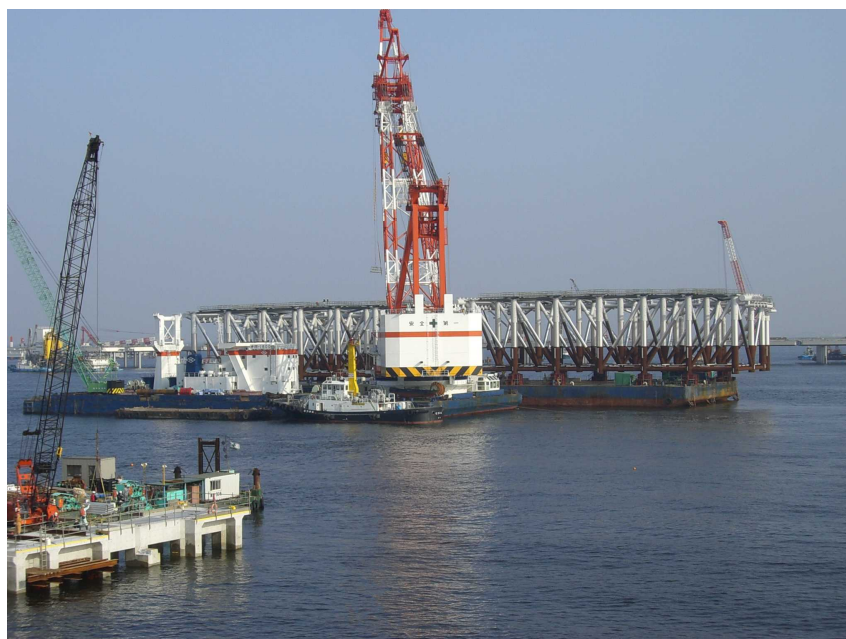
台船の上に載せられた連絡誘導路部ジャケット（D滑走路展望台より撮影）
