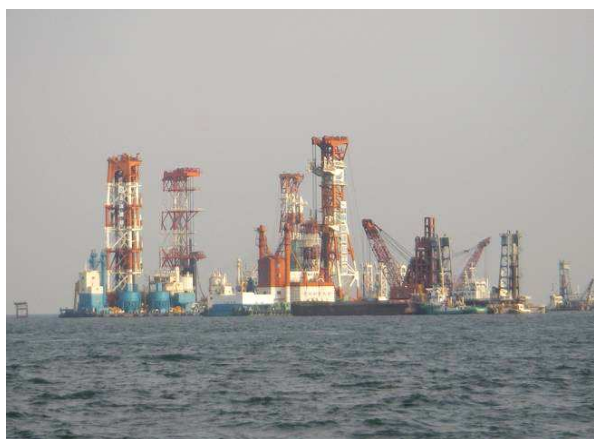
CDM船4隻による近接施工
