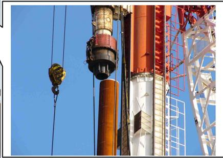
② 吊り上げた鋼管杭を杭打機に取り付けます。
