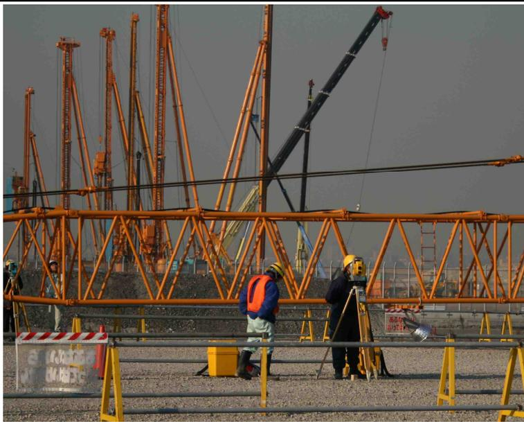
鋼管杭を打設する位置にズレがないか、傾いていないかを陸上側から測量機器でチェックします。
