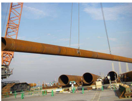
750t吊クレーンによる一本杭吊り上げ状況
