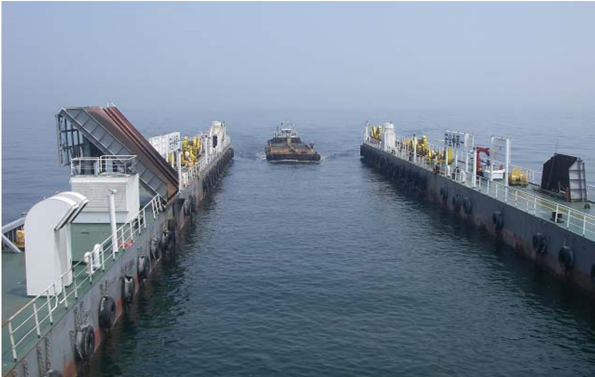
・土運船入渠
