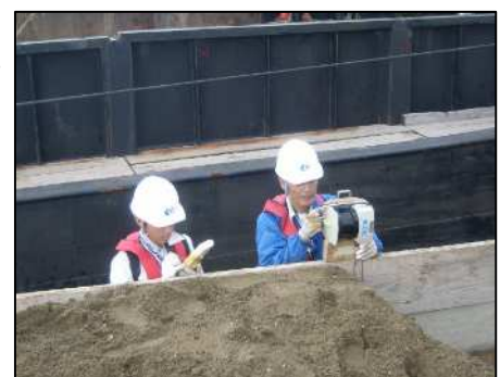
写真-3 土量検収状況
