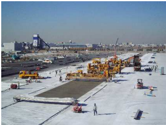
写真-2 施工状況 1
