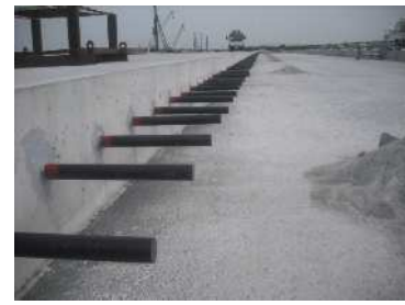
写真-17 バー固定状況
