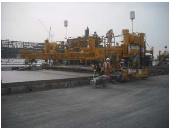
写真-4 施工状況 3
