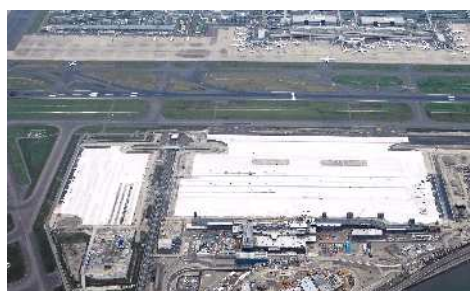
写真-1 全景写真
