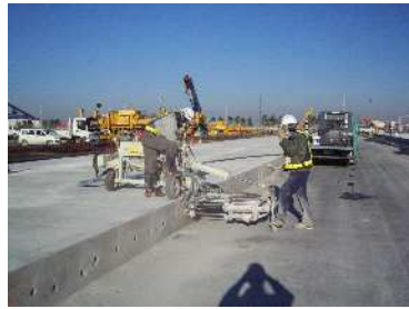
写真-16 穿孔状況
