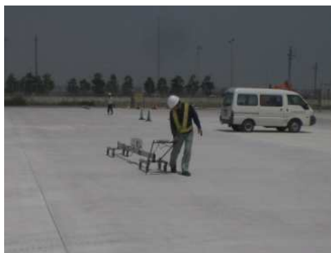
写真-22 平坦性の測定
