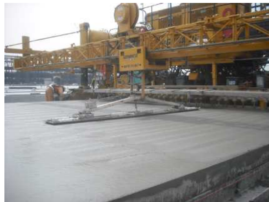
写真-5 施工状況 4
