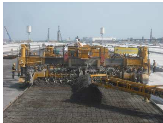
写真-3 施工状況 2
