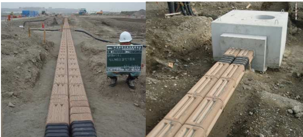
写真-5 多孔陶管の布設状況写真
