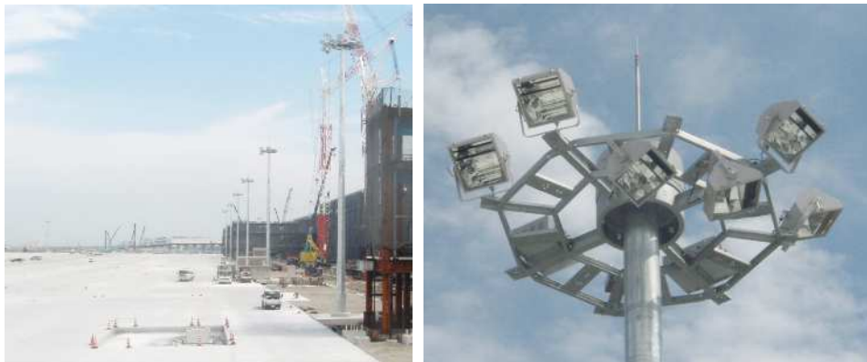
写真-2 エプロン照明灯の設置状況
