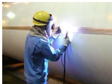
ライニング材を溶損させない補修溶接
