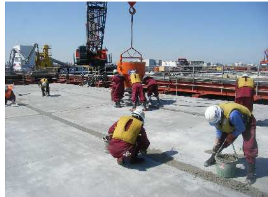
写真 5.5 目地コンクリート打設
