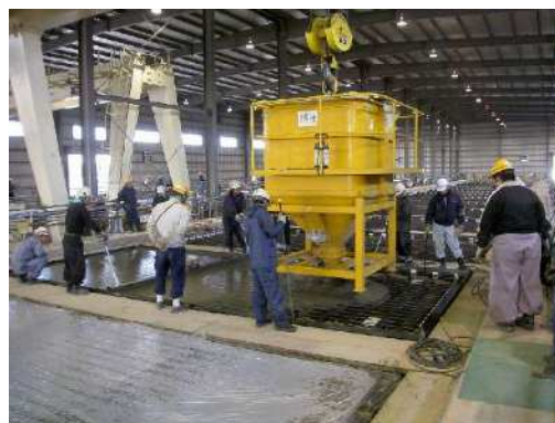
写真 3.7 UFC 打設状況
