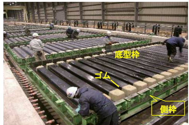
写真 3.2 型枠組立状況
