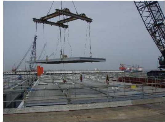
写真 5.3 UFC 床版架設
