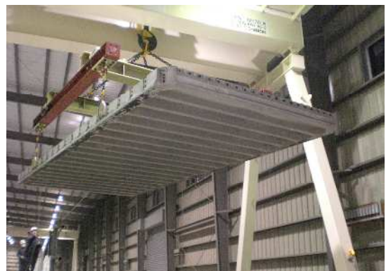
写真 3.10 床版運搬状況
