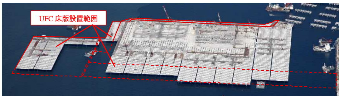
写真 5.6 栈橋工事施工状況全景（2009.4.27 撮影）
