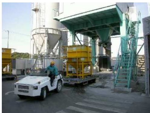
写真 3.6 UFC 運搬状況
