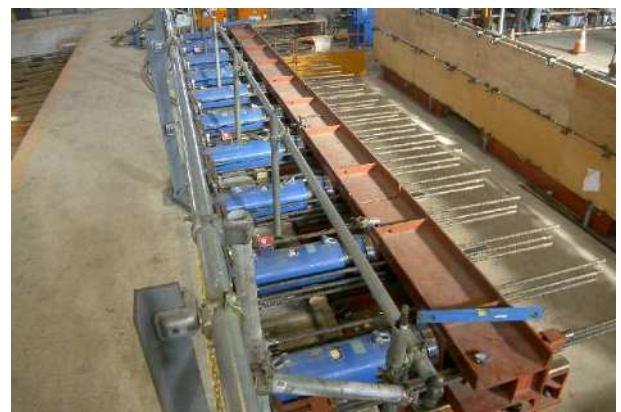
写真 3.4 主方向 PC 緊張状況 (ジャッキ)
