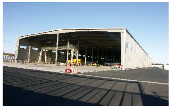
写真 3.1 製作ヤード上屋
