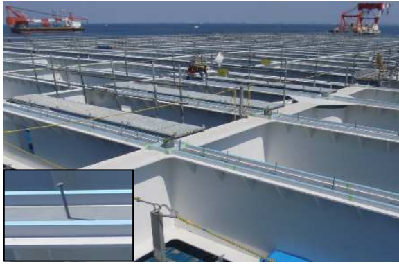
写真 5.2 沓座モルタル用型枠設置
