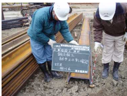
写真5 現場搬入時の品質確認
