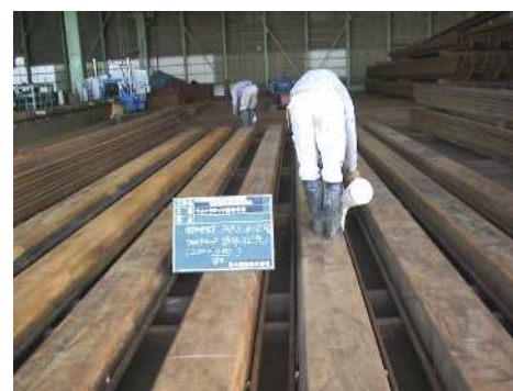
写真4 止水材の塗布状況
