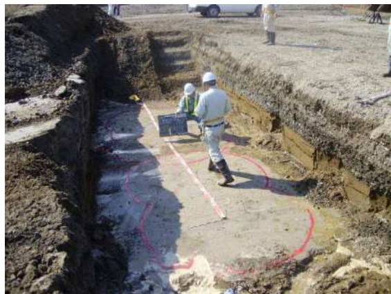
写真-3 試験施工出来形確認
