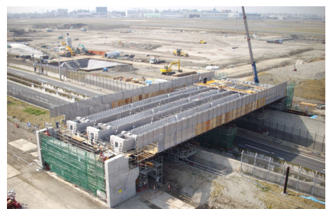
図 4.8 セグメント架設完了
