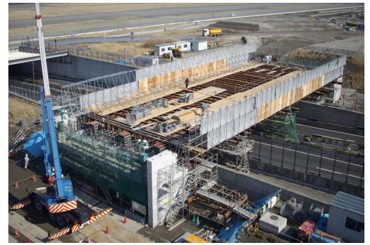
図 4.3 作業構台の設置状況
