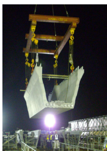
図 4.6 セグメント吊り治具
