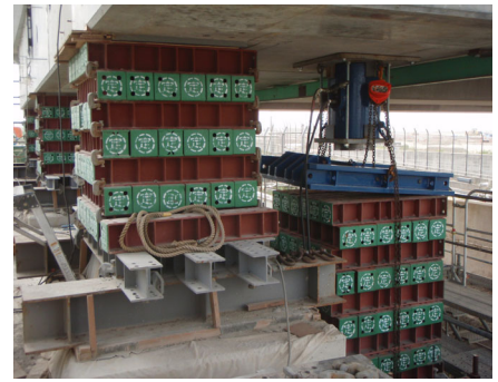
図 4.17 油圧ジャッキの設置状況
