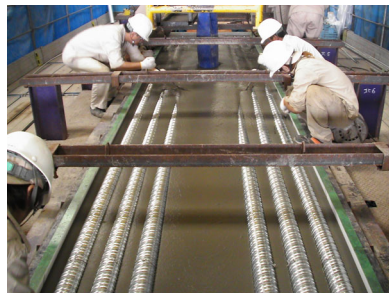
図 3.5 セグメントの UFC 打設状況
