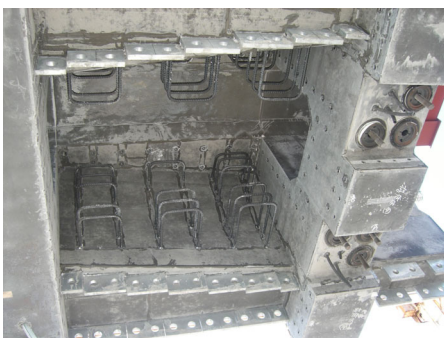
図3.11 端部セグメントの埋込み金物
