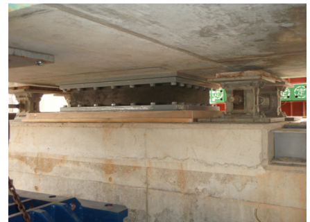
図 4.19 ゴム支承の接合状況
