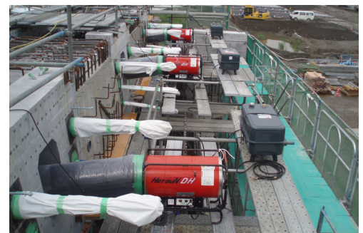
図 4.10 ウェットジョイントの養生方法
