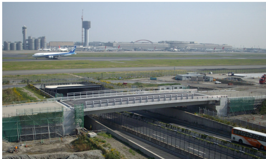
図 5.1 GSE 橋梁の完成写真
