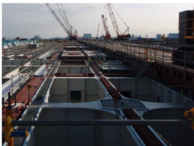
写真-6 PCa 床版架設前
