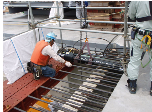
写真-13 PC 緊張状況
