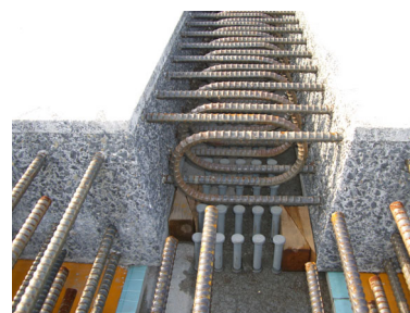
写真-5 PCa 床版ずれ防止
