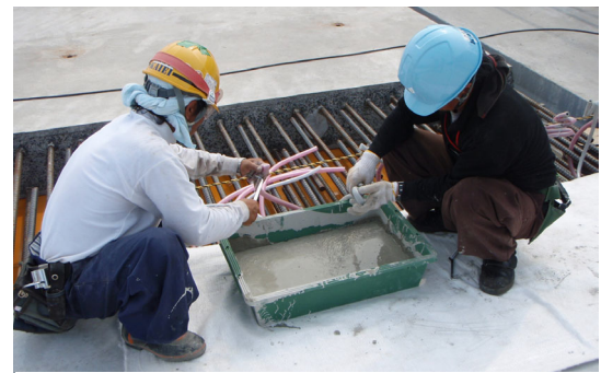
写真-18 PC グラウト排出側
