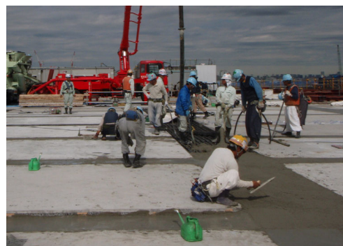
写真-9 標準部コンクリート打設
