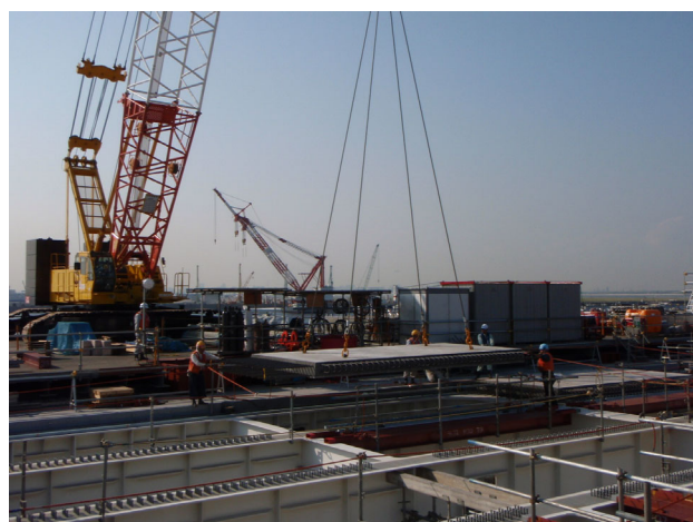
写真-7 PCa 床版架設状況
