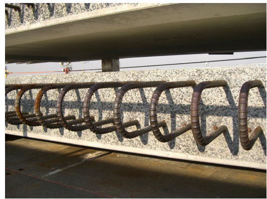
写真-2 PCa 床版打ち継ぎ面
