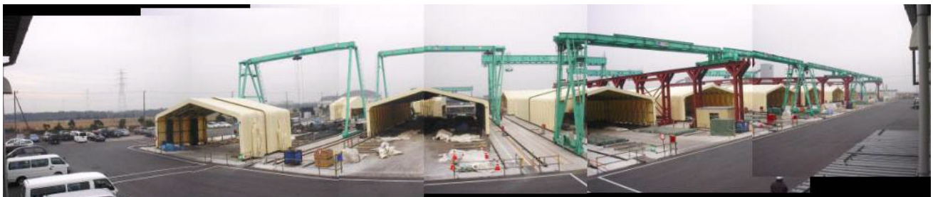
写真-1 床版製作工場全景
