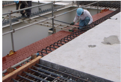
写真-12 PC 鋼線挿入
