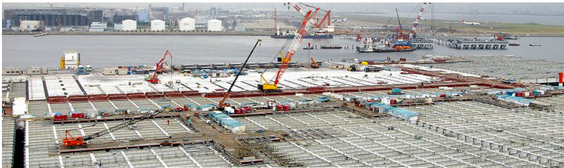
写真-19 ジャケット上施工状況全景
