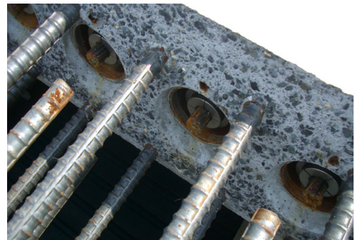
写真-14 PC 緊張完了・切断
