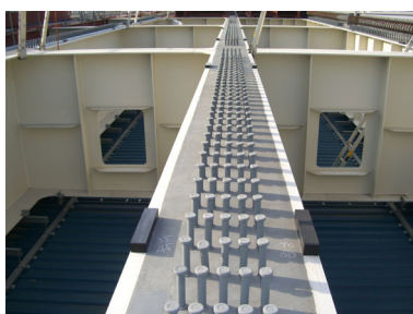
写真-4 高さ調整ゴム設置
