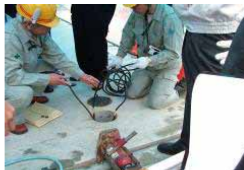
写真-8 開口部の作業性の確認状況
