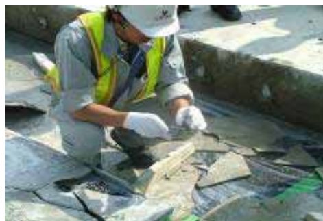
写真-11 グラウト材厚さの確認状況
