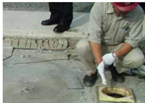
写真-7 灯火部周辺裏込め充填確認状況結果
