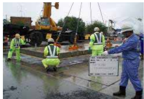
写真-5 P R C 版舗装据付け状況
