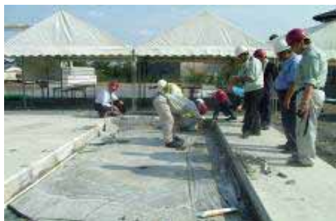
写真-10 充填性の確認状況
