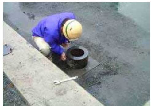
写真-6 下部基台設置状況
