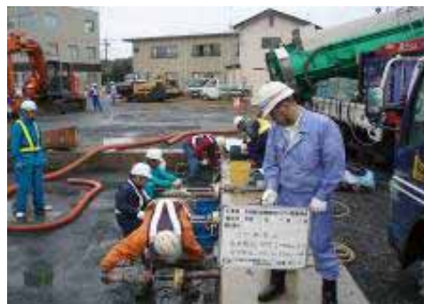
写真-9 水平削孔の作業状況
