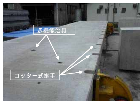
写真-1 P R C舗装版の構造
