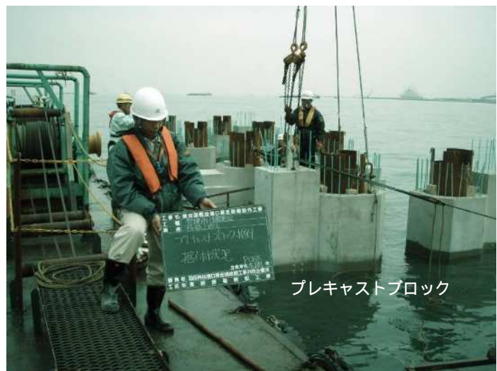
写真4-2 プレキャストブロック設置状況
