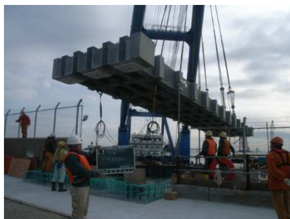
写真 3-4 渡り橋の架設状況(現地)
