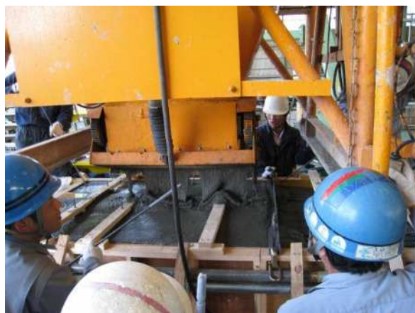
写真 3-2 UFC の打込み状況
