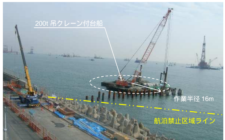
写真 4-1 クレーン付台船配置状況
