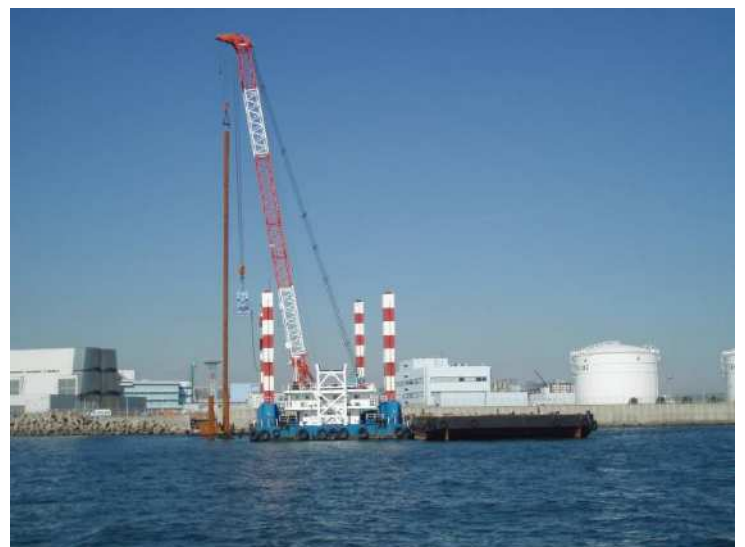
写真4-3 鋼管杭打設状況
