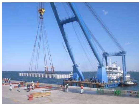
写真 3-3 渡り橋の浜出し状況(中袖製作ヤード)
