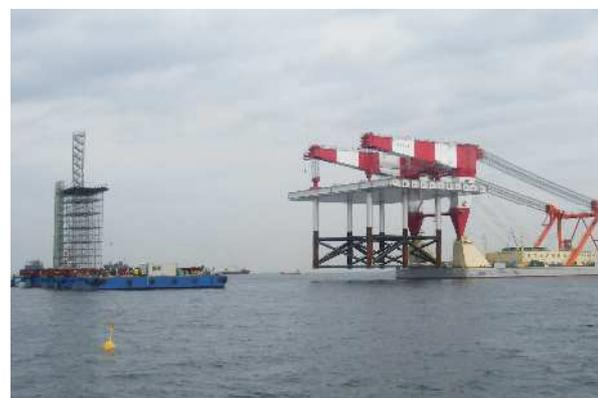
写真-5.4 ジャケット運搬台船係留解除
