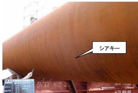
写真-7.1 シアキー（鋼管杭外面）
