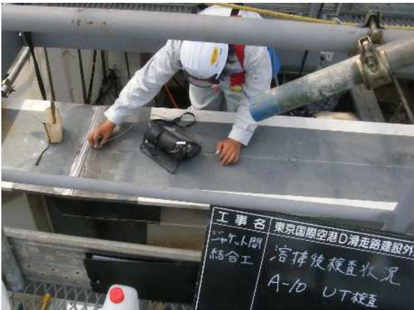
写真-8.5 溶接部非破壊検査
