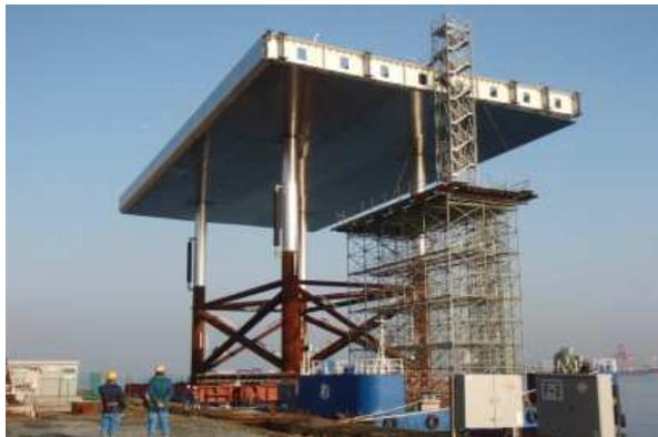
写真-5.1 ジャケット工場浜出し
