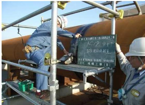
写真-3.7 溶接部検査
