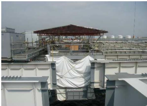
写真-8.1 雨対策用屋根設置状況
