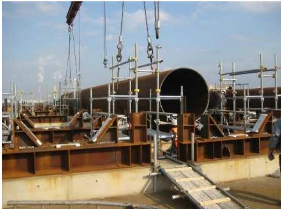
写真-3.4 素管の溶接架台上設置
