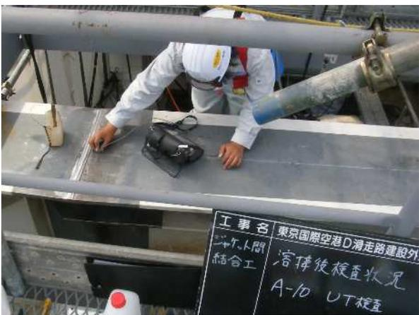
写真-8.5 溶接部非破壊検査
