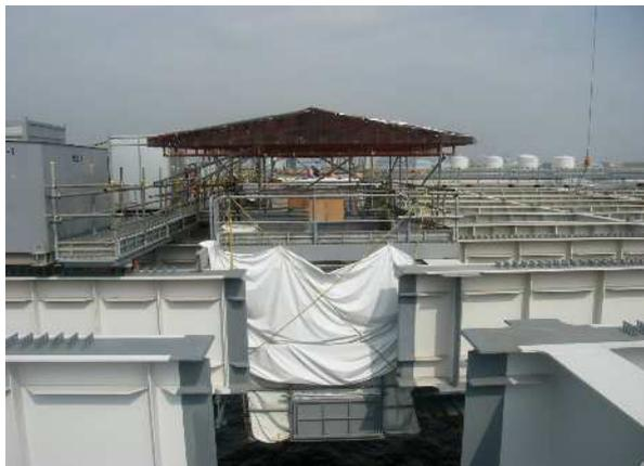
写真-8.1 雨対策用屋根設置状況
