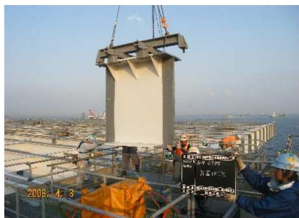
写真-8.2 結合材設置状況
