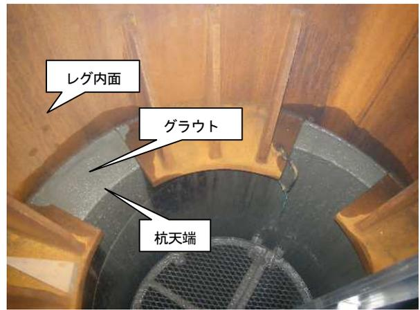
写真-7.5 グラウト充填確認（レグ内部）
