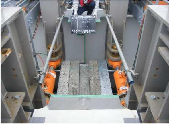
写真-8.3 遊間調整用ジャッキ設置状況
