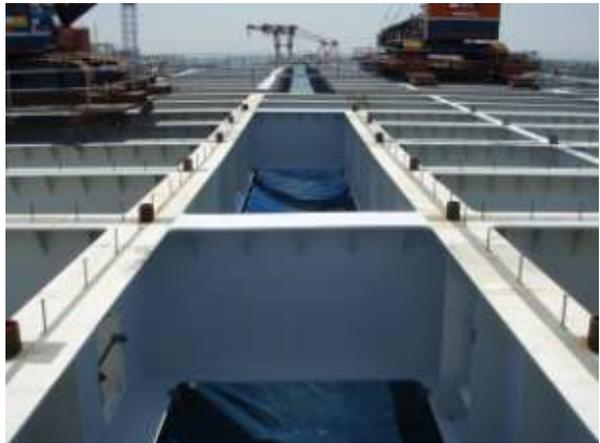
写真-8.6 ジャケット間結合工完了
