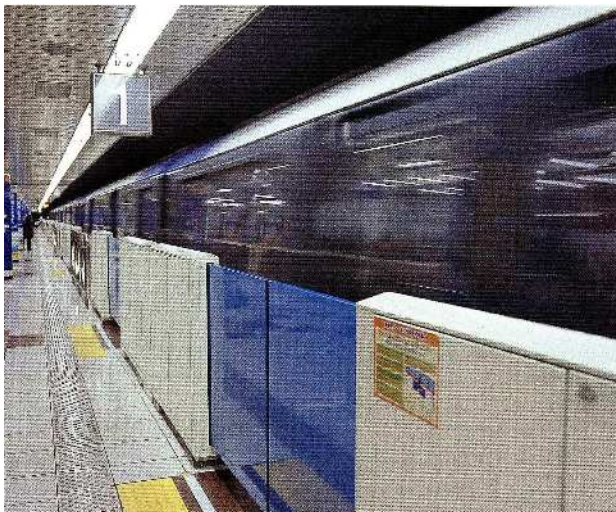
図-9 可動式安全柵設置状況
