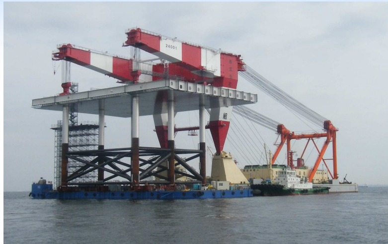
ジャケット玉掛け・水切り
