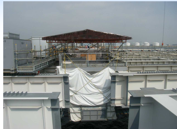
足場設置・風雨養生・遊間調整
