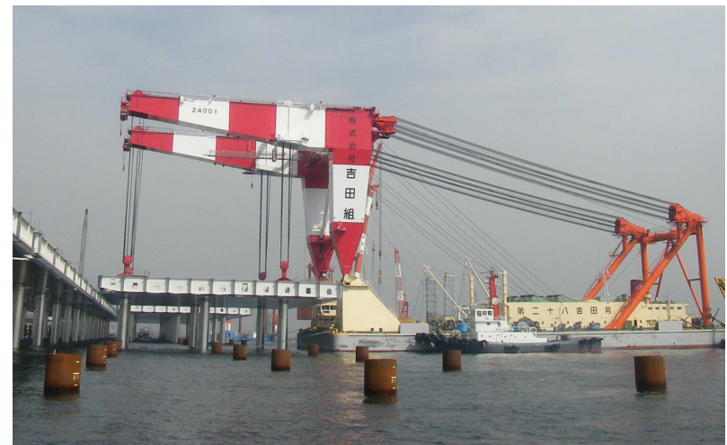
据付・位置確認
