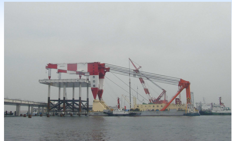
据付位置にシフト
