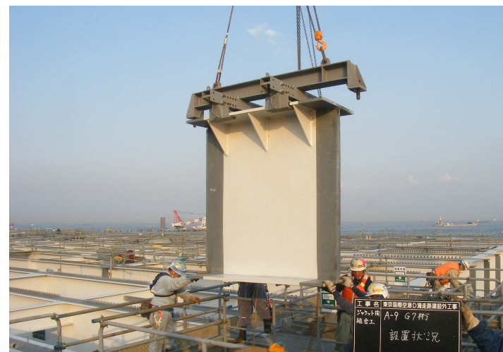
結合材切断・設置
