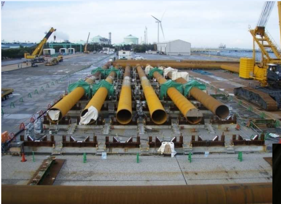
加工場溶接状況
