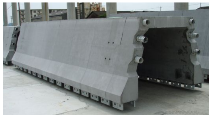
写真-1 UFC プレキャスト桁
