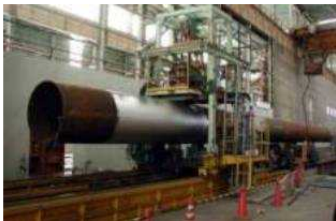
ライニング状況
