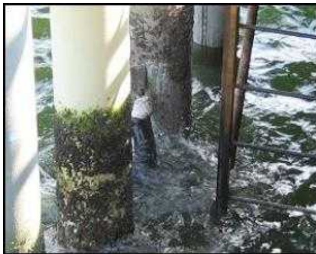
排貝作業状況
