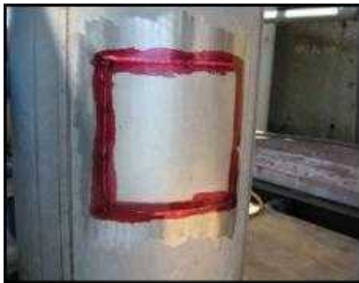
浸透探傷試験状況
