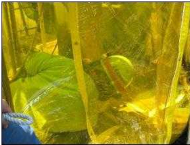
溶接補修作業状況
