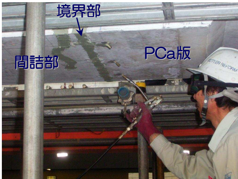
ひび割れ補修材注入状況
