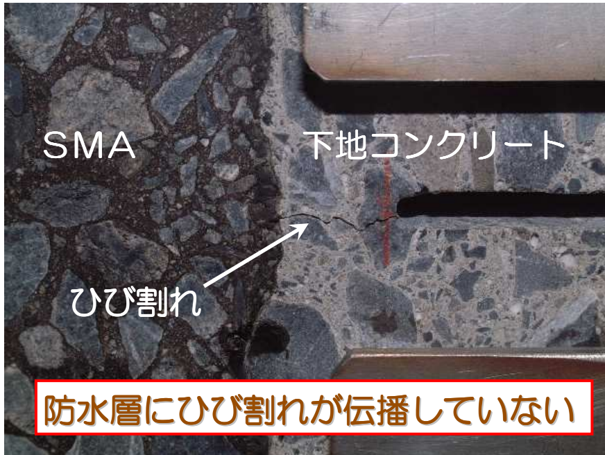
ひび割れ開閉負荷後の状況
