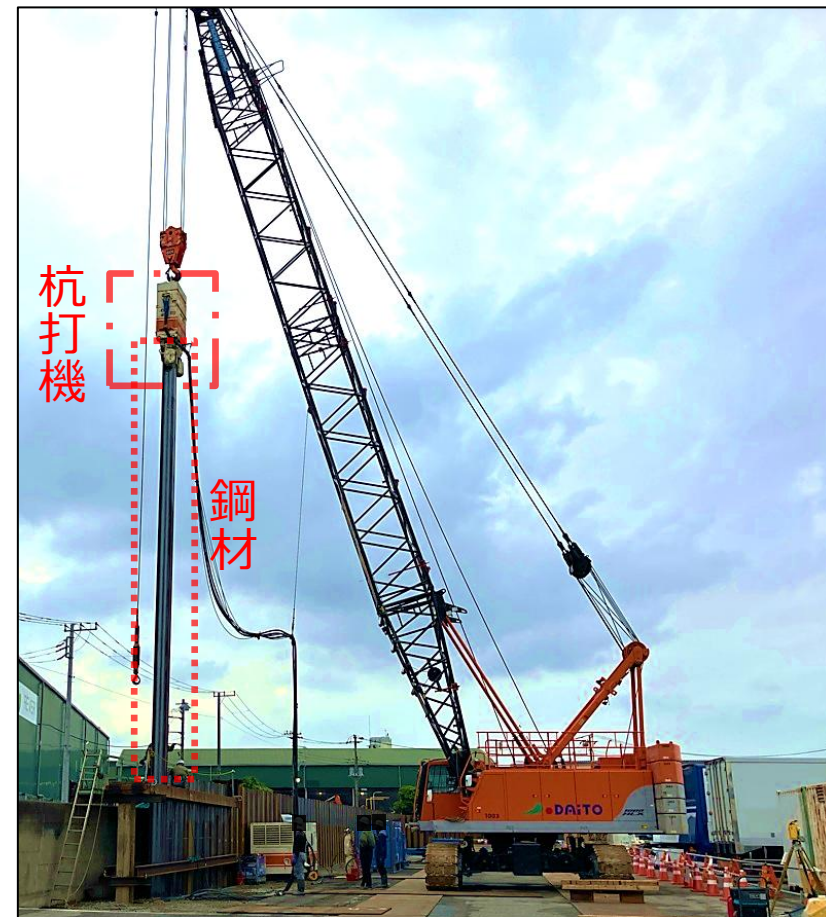
鋼材打設の様子 (参考)
