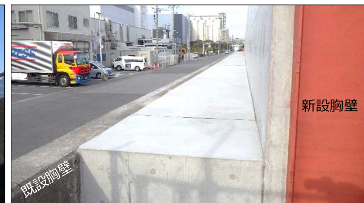
工事完了状況(新設胸壁と既設胸壁との間)
