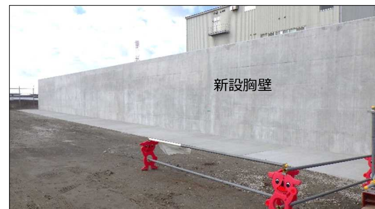
工事完了状況(新設岸壁側)
