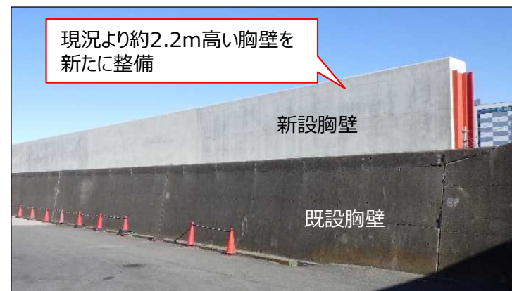
工事完了状況(既設胸壁側)
