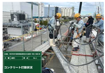
上部工(コンクリート打設)施工状況
