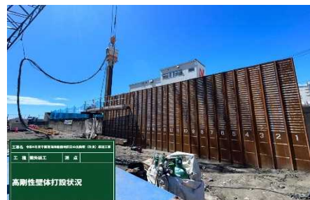
本体工(高剛性壁体打設)施工状況
