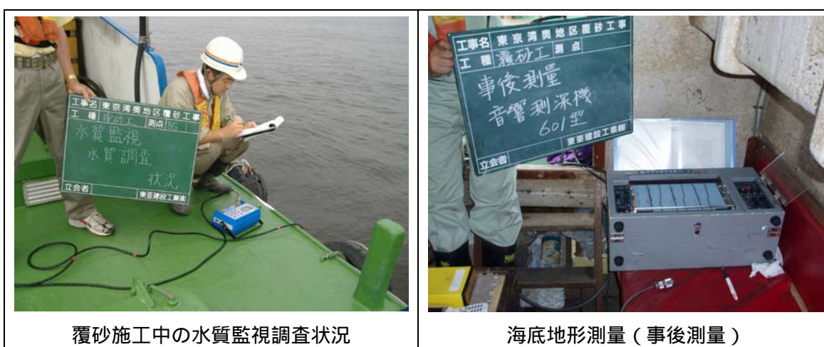
図 3-15 施工中水質監視調査、施工後海底地形測量状況
