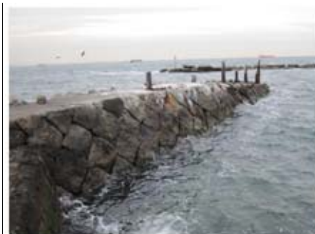
写真-3.3.2 繫船場(石積) (2013.10 撮影)
