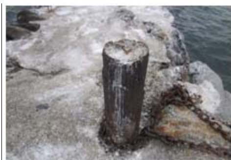
写真-3.3.3 係船柱 (2013.10 撮影)
