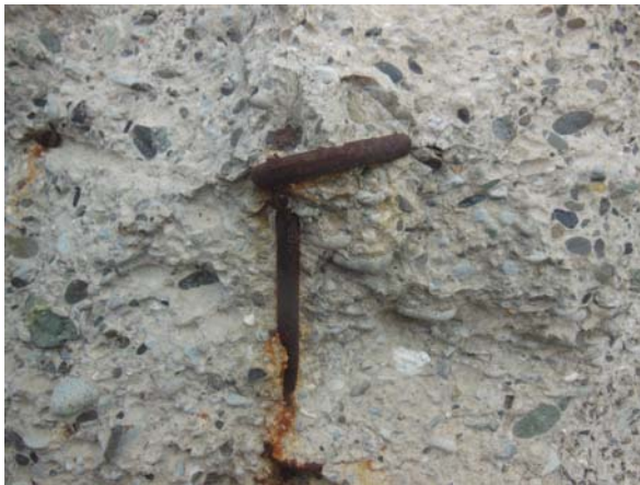
写真-3.6.13 27cm 加農砲塔砲台④の基礎コンクリートブロック
