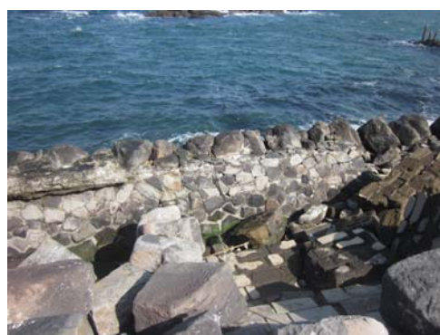
写真-3.2.4 護岸背後状況(モルタル)(2013.8撮影)
