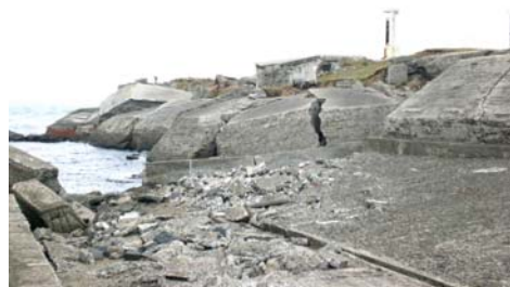
写真-3.2.7 第二海堡西側護岸の崩壊箇所 (汀線が砲台まで浸食 2004.8 撮影)
