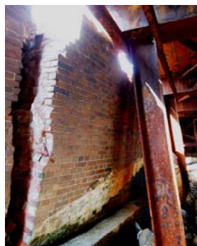
写真-3.2.6 第二海堡北側掩蔽壕の崩壊箇所 (前面海側への倒れ込み 2014.8 撮影)
