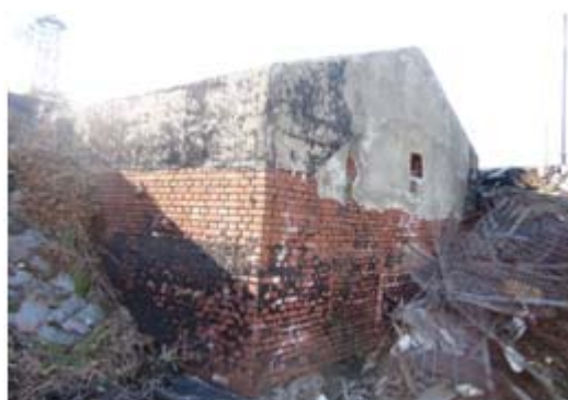
写真-3.7.3 東側掩蔽壕繋船場前倉庫（2013.8撮影）
