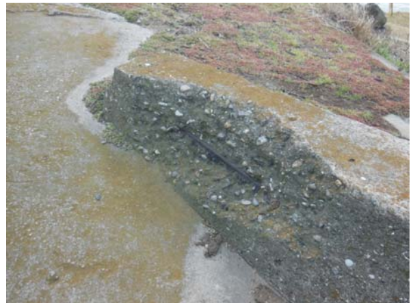
真-3.6.14 27cm 加農砲台⑤の上部に存在する鉄筋コンクリート中の鉄筋
