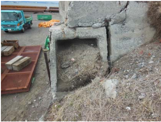
写真-3.6.11 27cm 加農砲塔砲台④の左側箱型構造体
