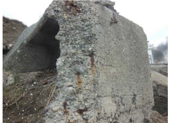
写真-3.6.12 27cm 加農砲塔砲台④の右側箱型構造体
