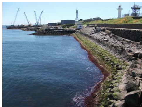
写真-3.2.2 北側繫船場護岸(2013.8撮影)
