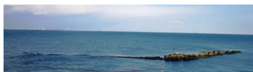
写真-3.4.1 防波堤全景 (2014.3 撮影)
