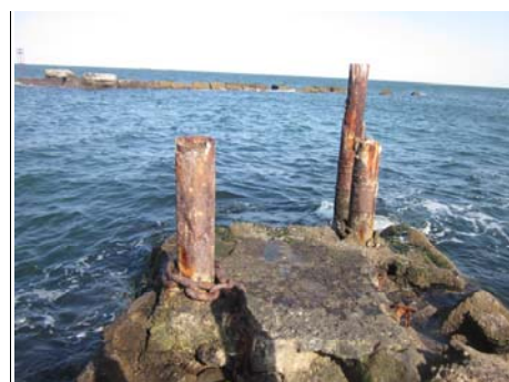
写真-3.3.4 繫船場(先端部) (2014.1 撮影)
