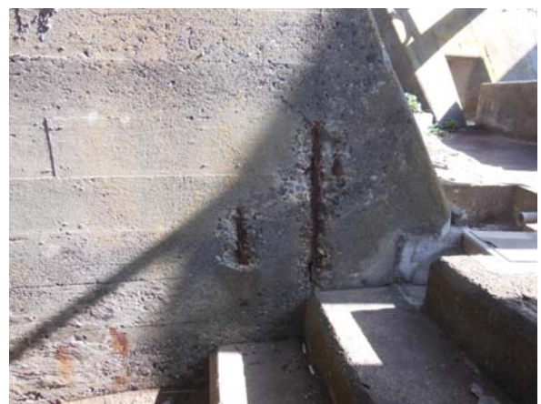
写真-3.6.9 12.7cm 高角砲台①の箱状構造体側面
