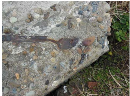
写真-3.6.15 15cm 加農砲塔砲台近傍に存在した鉄片を含むコンクリートブロック
