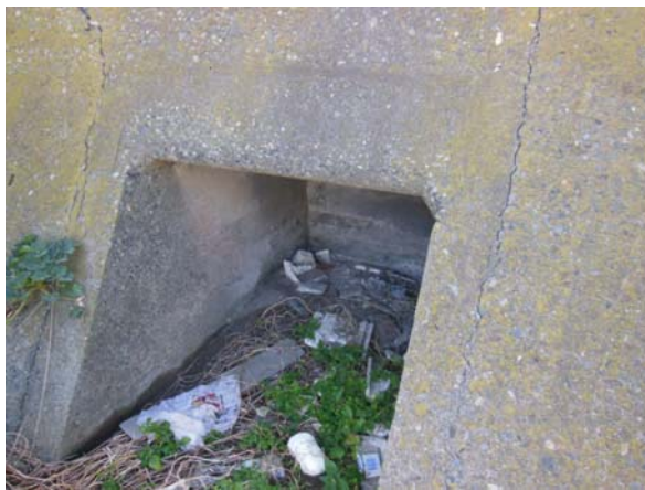
写真-3.6.8 15cm 加農砲塔砲台①の箱状構造体
