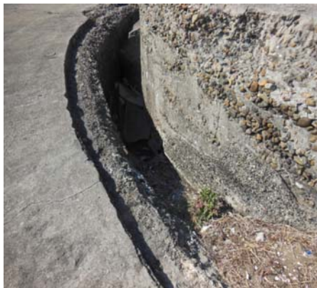
写真-3.6.10 15cm 加農砲塔砲台③の砲台本体と巻立てコンクリート
