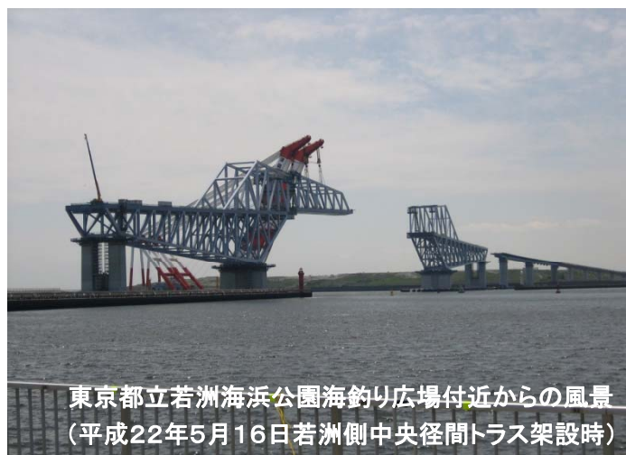
工事の様子（5月16日若洲側中央径間トラス架設時）
