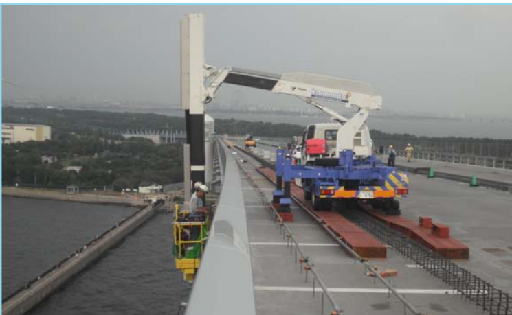
③ 若洲側工事状況
