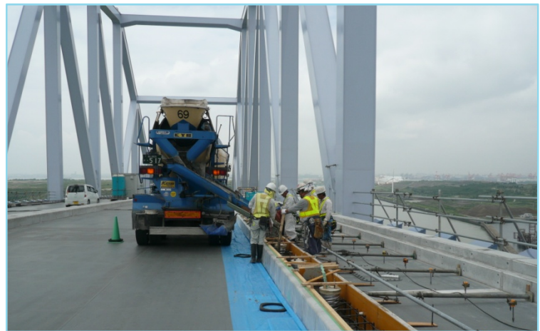
② 橋梁中央付近工事状況
