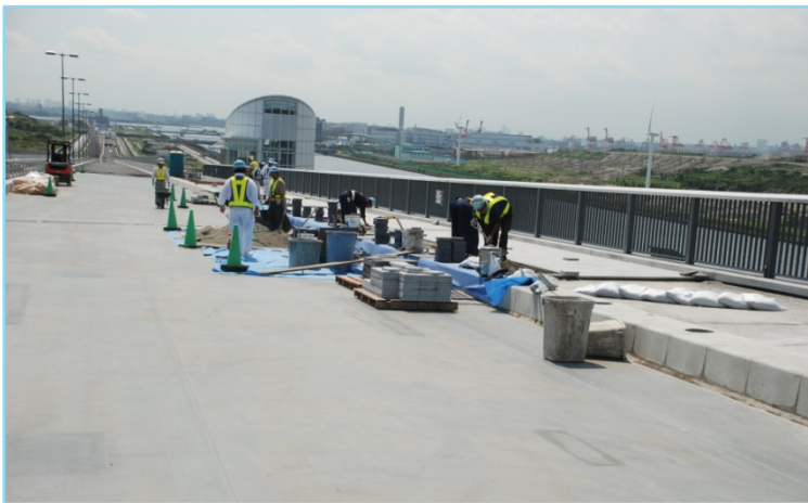
① 中央防波堤側工事状況
