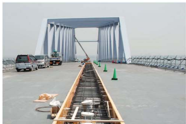
<橋面上の工事状況(5月末時点)>
