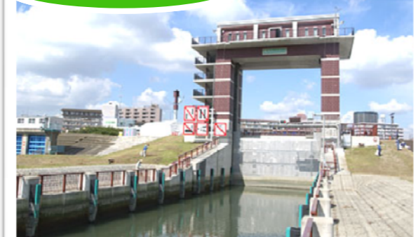
荒川ロックゲート
